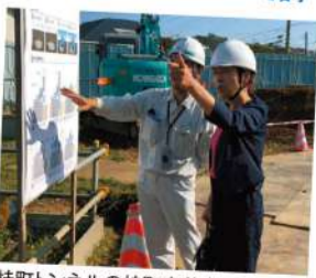
桂町トンネルの桂町交差点側、鋼管杭圧入工事施工方法の説明
